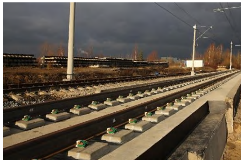
ОАО «РЖДстрой» – конструкция LVT
