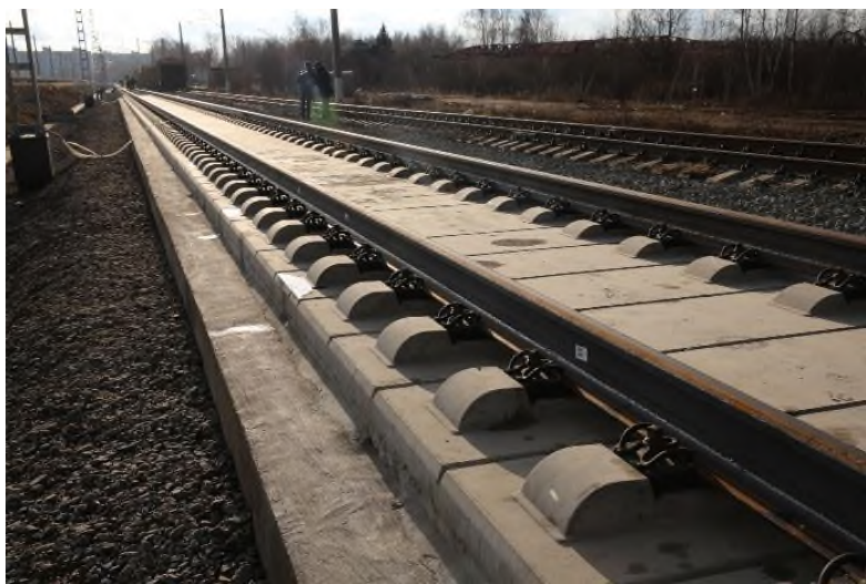
Max Bögl – конструкция FF-Bögl
