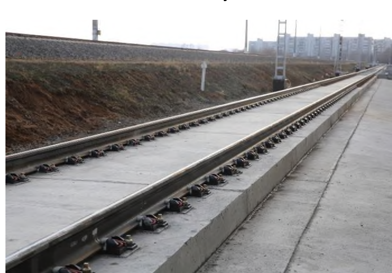
ALSTOM – конструкция NBT
