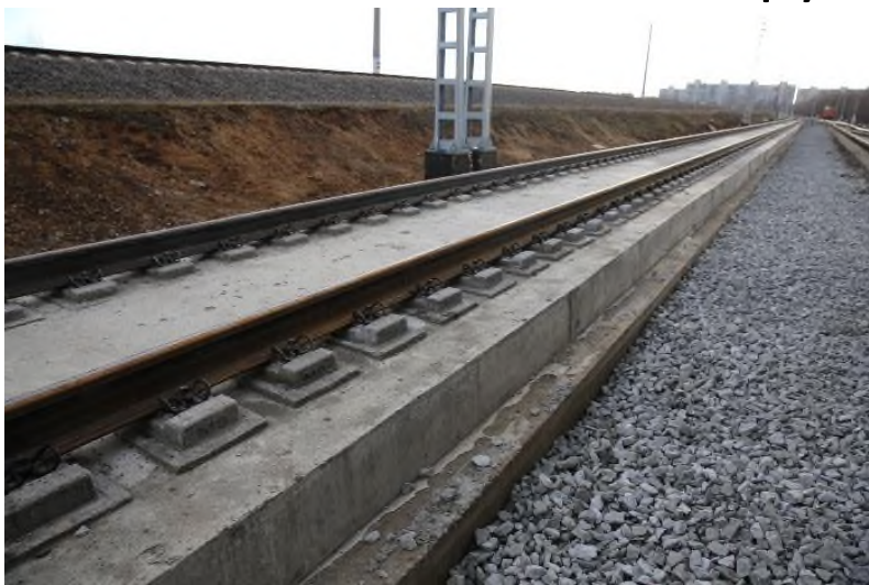
TINES – конструкция EBS
